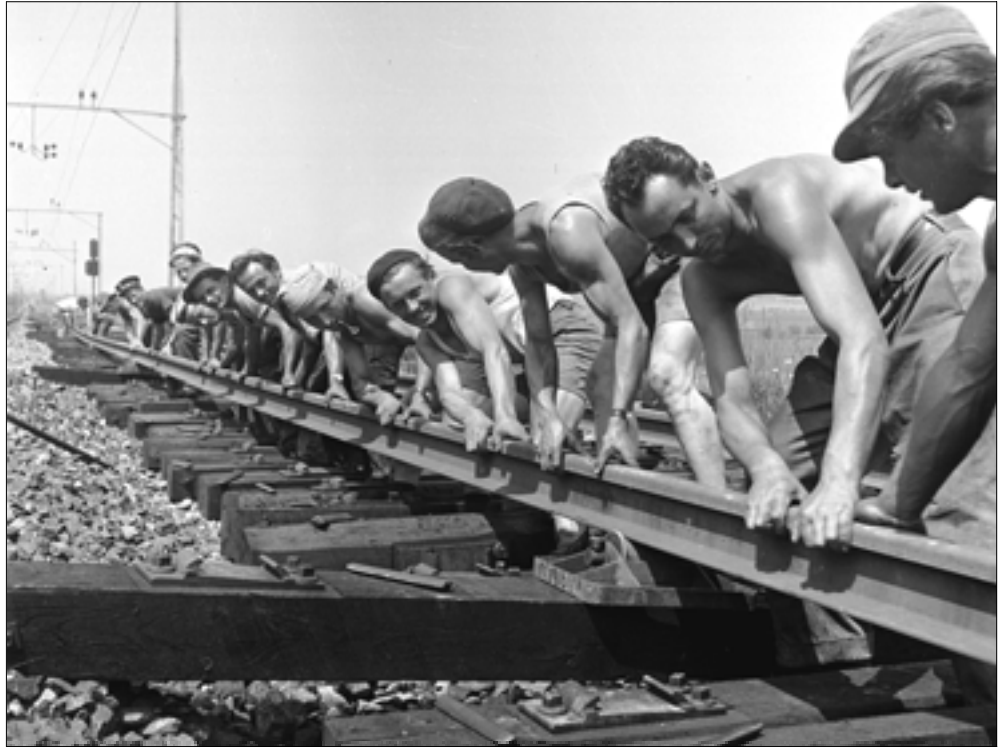
Abb. 23: Der Bau der Eisenbahntrassees im 19. und anfangs des 20. Jahrhunderts verschlang grosse Mengen Eichenholz und führte zu einer starken Übernutzung des schweizerischen Eichenbestandes. (Bild Fotoarchiv SBB Historic)
