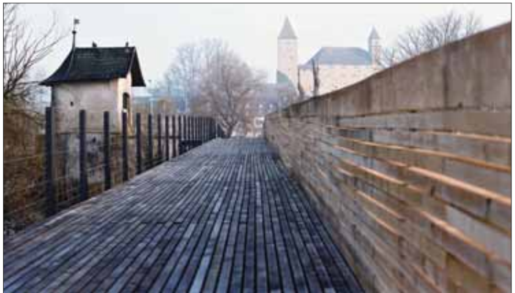
Abb. 39: Am 6. April 2001 wurde der Öffentlichkeit ein neuer Holzsteg über den Zürichsee zwischen Rapperswil SG und Hurden SZ übergeben. Dank der Zusammenarbeit und frühzeitigen Planung von Bauherrschaft, Ingenieuren und Architekten einerseits und der Forst- und Holzwirtschaft andererseits stammen rund 70% des verwendeten Eichenholzes für dieses Grossprojekt aus Schweizer Eichenwäldern: ein Beispiel für funktionierenden Informationsfluss in der Holzkette [63] . (Foto Katharina Wernli)
